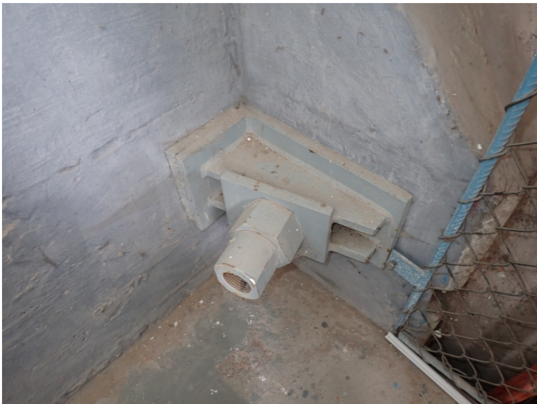
Foto 38: Kotvení horního táhla za stěnou.
