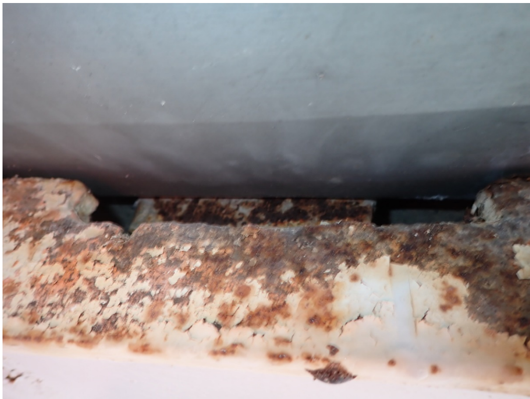
Foto 36: Mezi podpěrou a samotnou konzolou jsou instalovány ocelové klíny celkem 4x pro aktivaci podepření mezi ocelovou konstrukcí a žb. konzolou. Ocelové klíny jsou napadeny masivní korozí, úbytek odhadujeme v řádu 1 mm.
