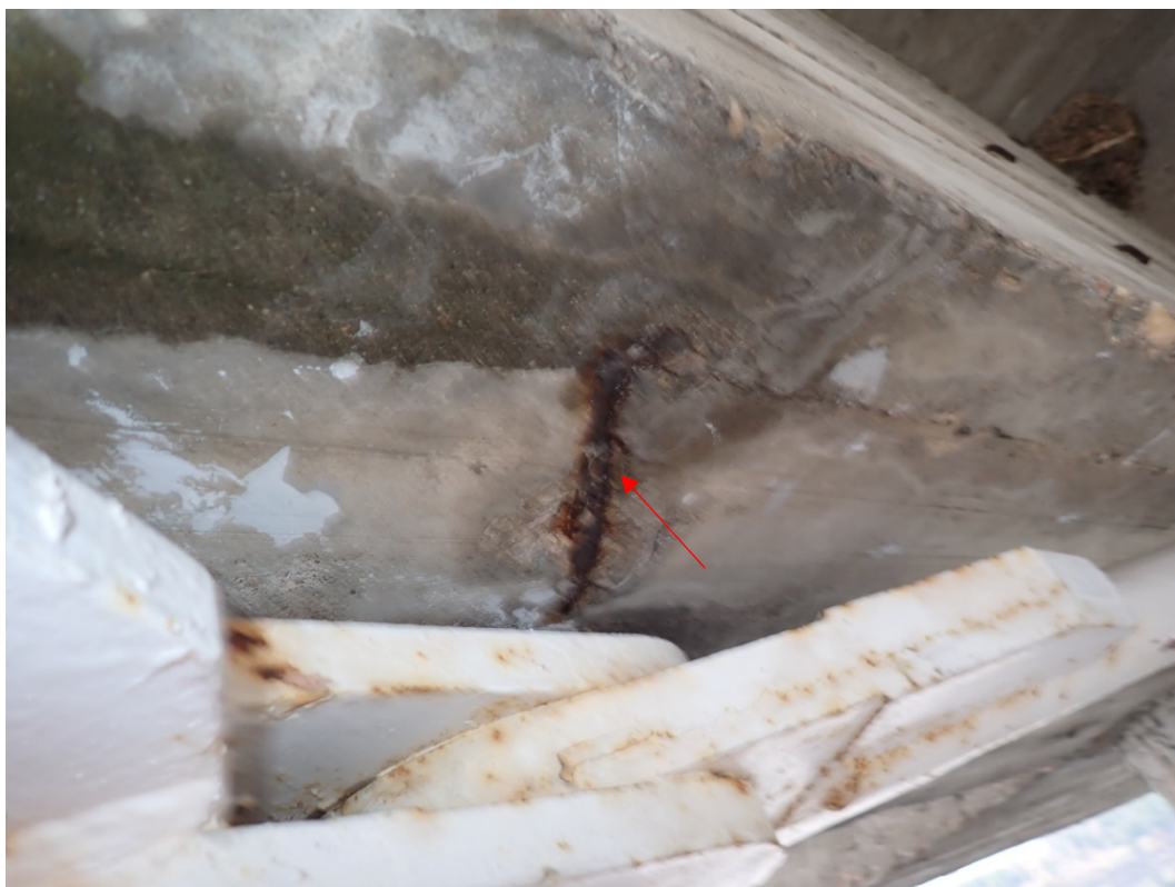
Foto 9: Koroze distančních podložek, malé krytí výztuže 2x.
