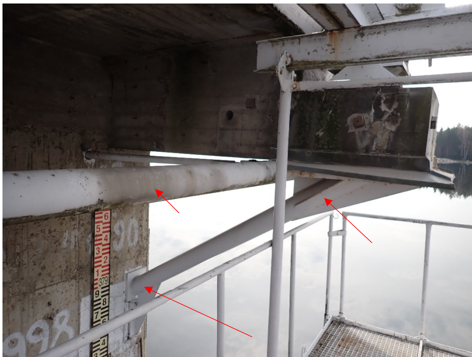
Obr. 6: Pohled na dodatečné podepření konzol.
