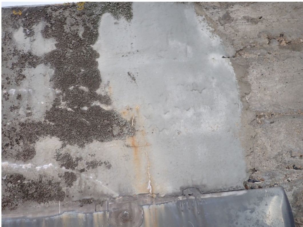
Foto 20: Šikmá trhlina šíře 0,5 mm na rozhraní nižší/vyšší části konzoly.
