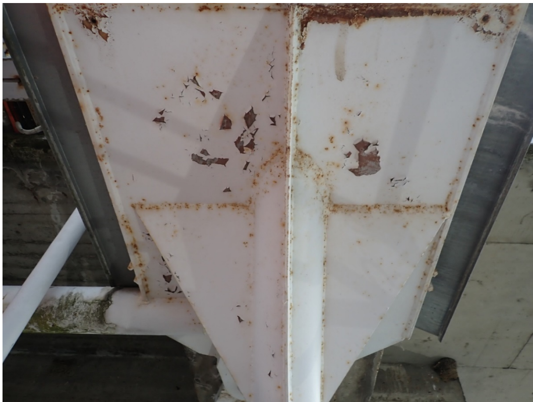
Foto 33: Ocelová podpěra pod konzolou, poškozené PKO, lokálně povrchová koruze.
