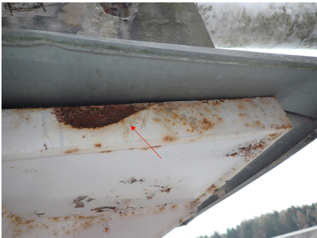
Foto 34: Kolem podpěry je přivařen ztužující plech, který vytváří možnost hromadění vody mezi podpěrou a konzolou, odtokové díry jsou zanesené rží. Dodatečně byl instalován ochranný pozinkovaný plech proti srážkové vodě.
