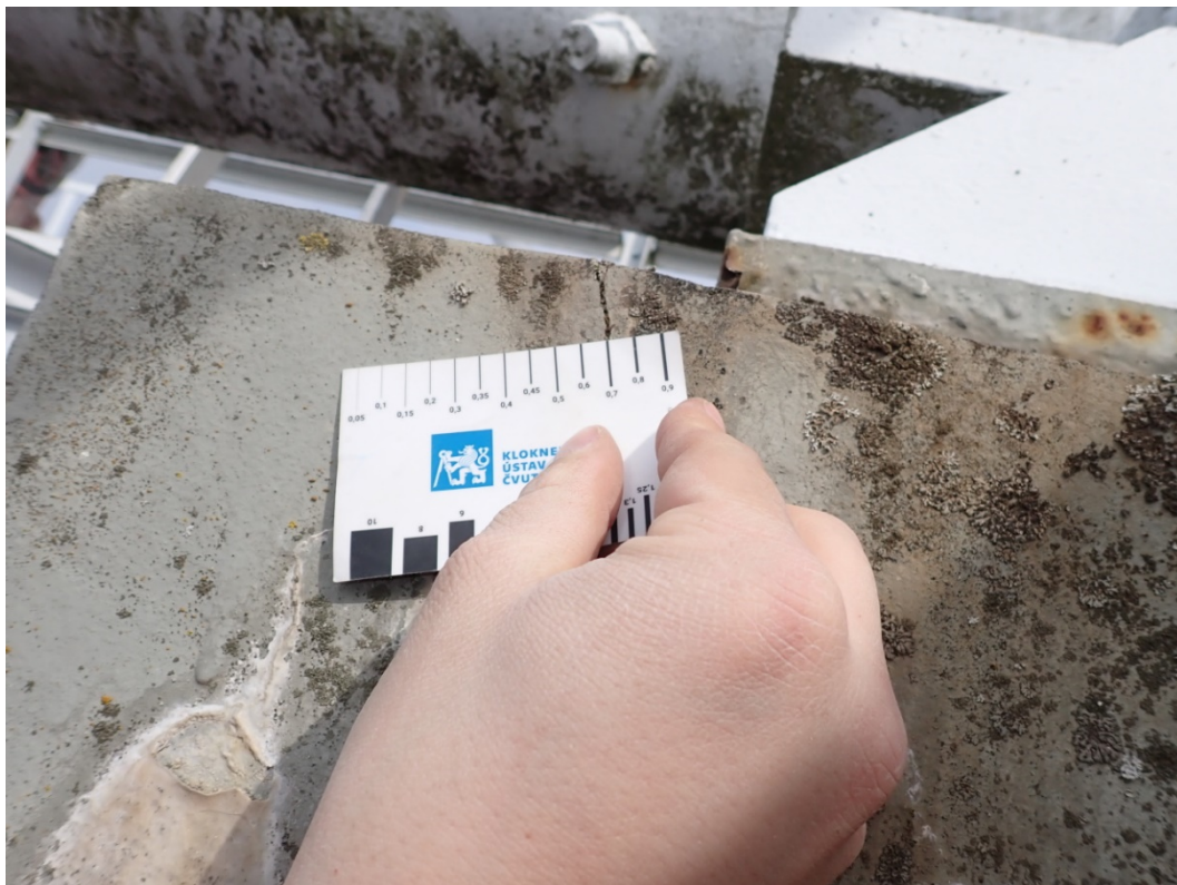
Foto 18: Šikmá trhlina šíře 0,7 mm pod hranou ložiska.
