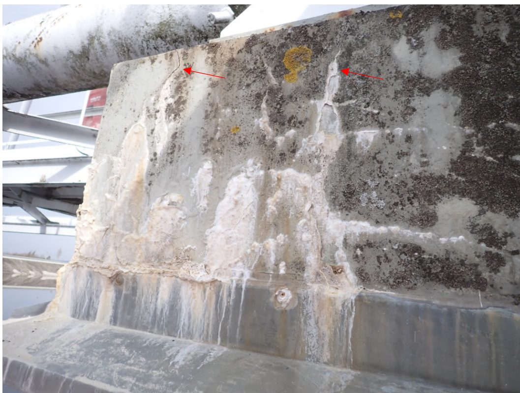
Foto 17: Šikmá trhlina 3x, šíře 0,7 mm, 0,35 mm a 0,05 mm.
