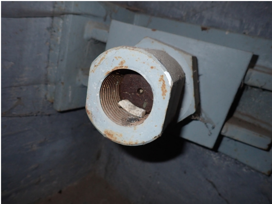
Foto 39: Kotvení horního táhla za stěnou.
