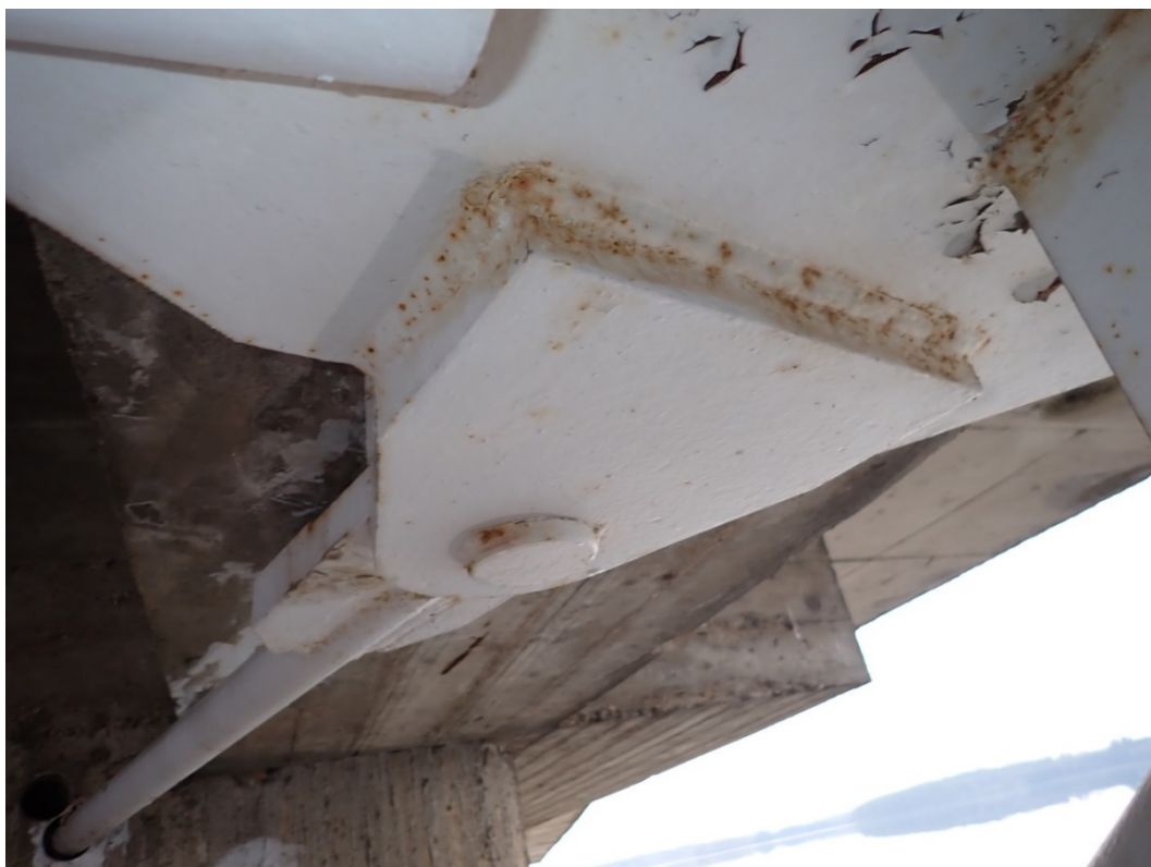
Foto 30: Horní táhlo dodatečného podepření, poškozené PKO, lokálně povrchová koroze.
