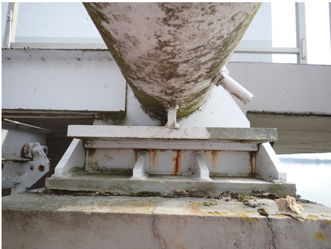
Foto 23: Čelné pohled na ložisko LK, lokálně loupání PKO korozní výluhy.
