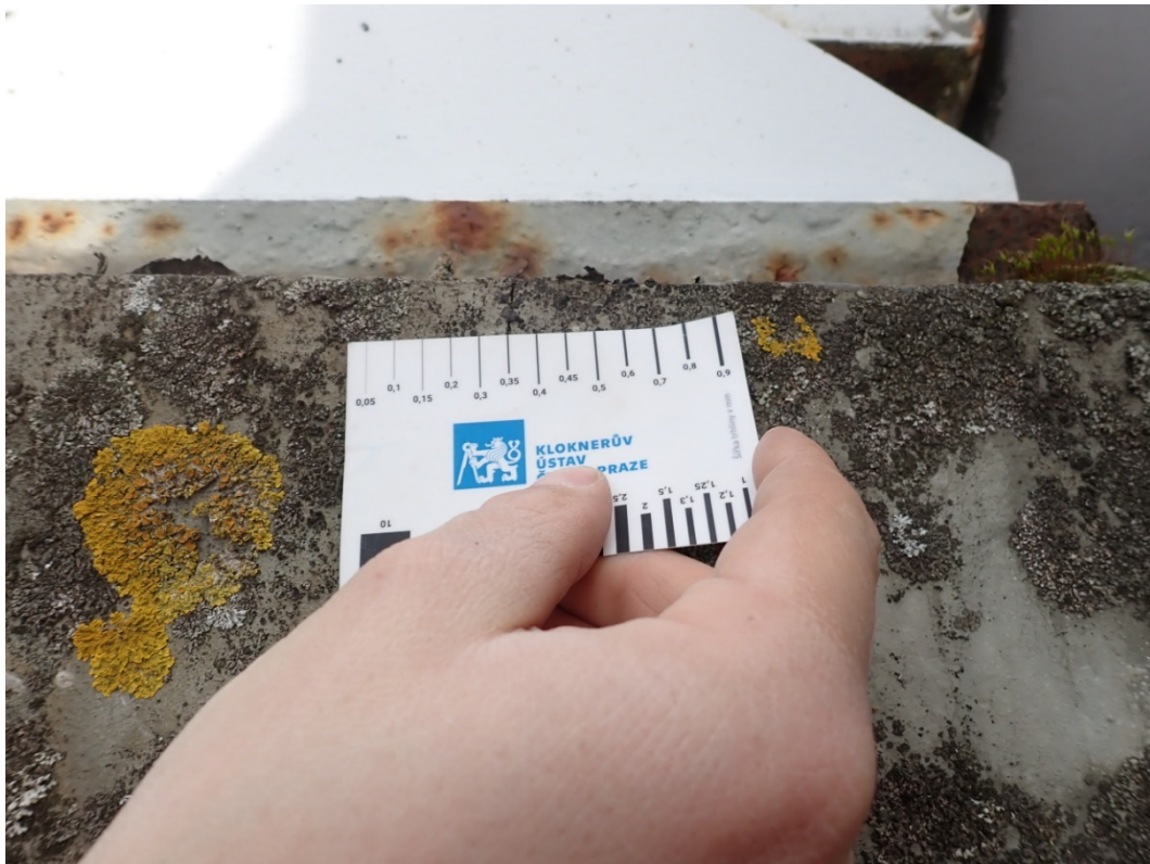
Foto 19: Šikmá trhlina šíře 0,35 mm pod ložiskem.
