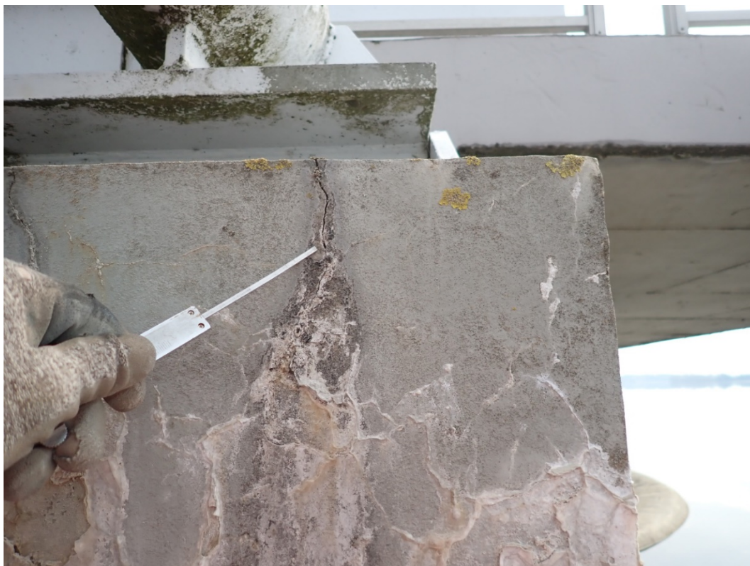
Foto 15: Svislá trhlina na čele konzoly 0,4 mm s výluhy.
