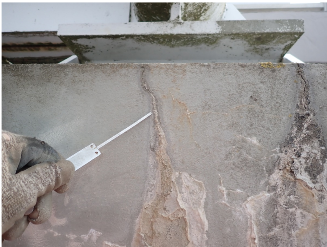
Foto 14: Svislá trhlina na čele konzoly 0,1 mm s výluhy.
