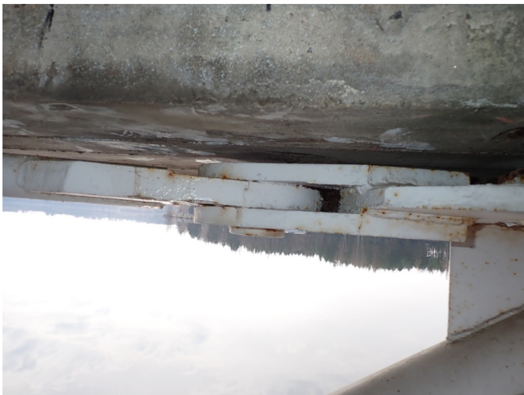
Foto 29: Horní táhlo dodatečného podepření, poškozené PKO, lokálně povrchová koroze.
