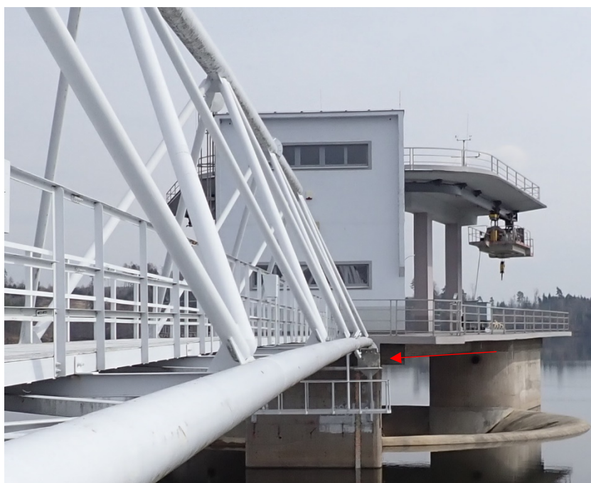
Foto. 1: Celkový pohled na konstrukci lávky SO VD Švihov a uložení na konzolu.
