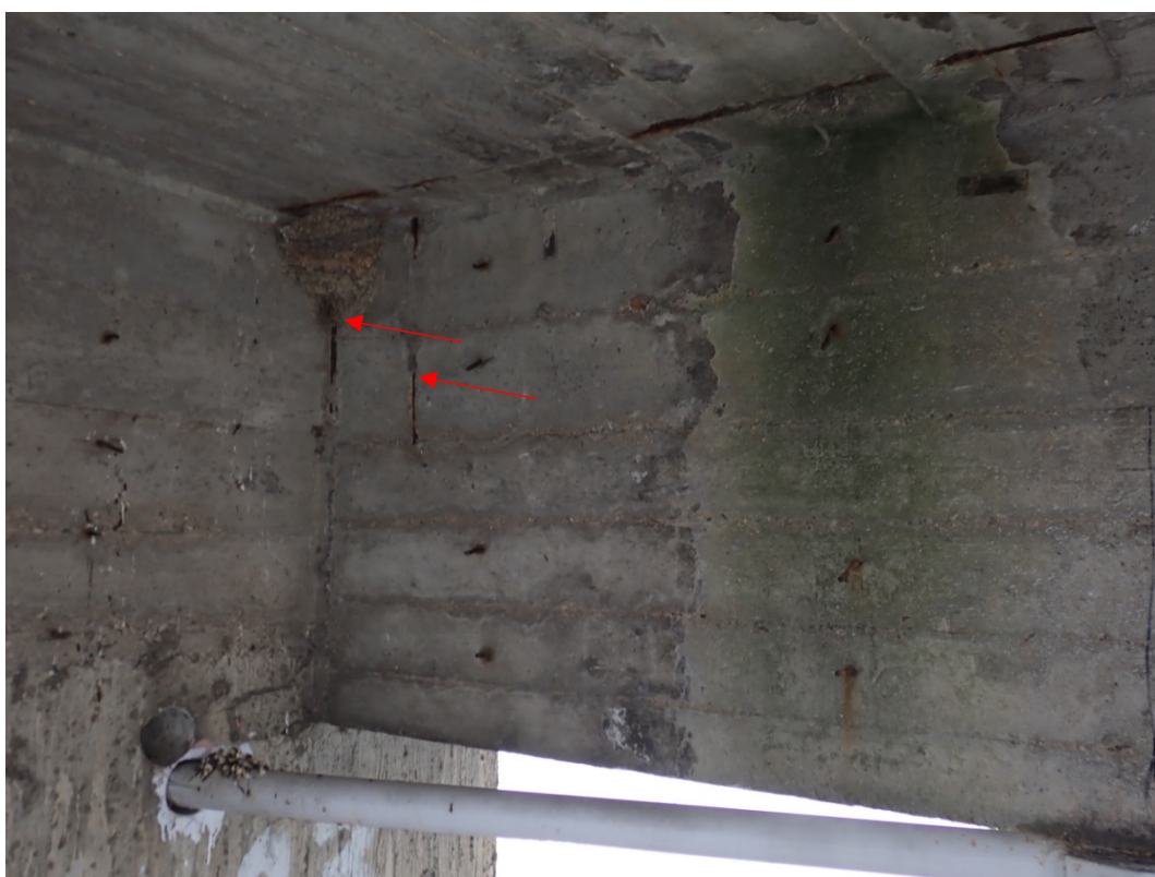
Foto 12: Koroze třmínek (bez významného oslabení), malé krytí výztuže 2x prut délka cca 20-30 cm.
