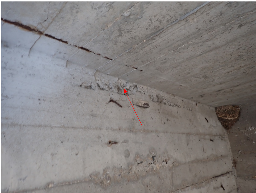
Foto 3: Nprobetonovaná část konzoly šíře cca 10 cm, délka 0,5 m.
