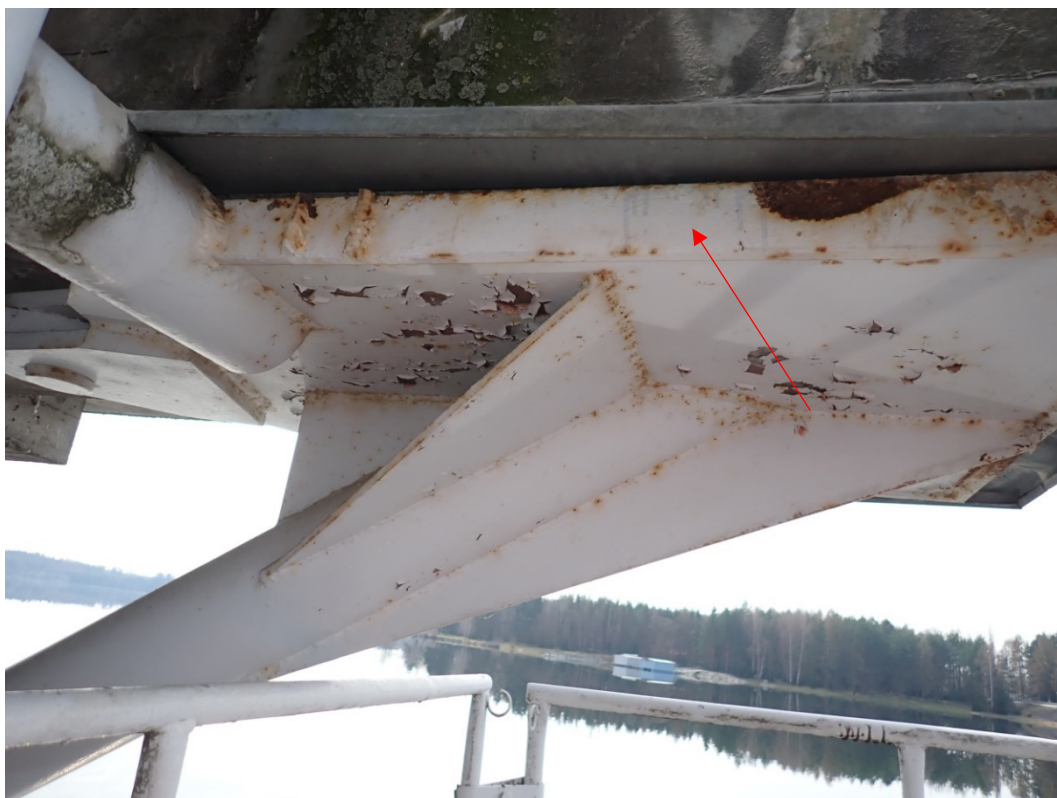
Foto 32: Ocelová podpěra pod konzolou, poškozené PKO, lokálně povrchová koroze.
