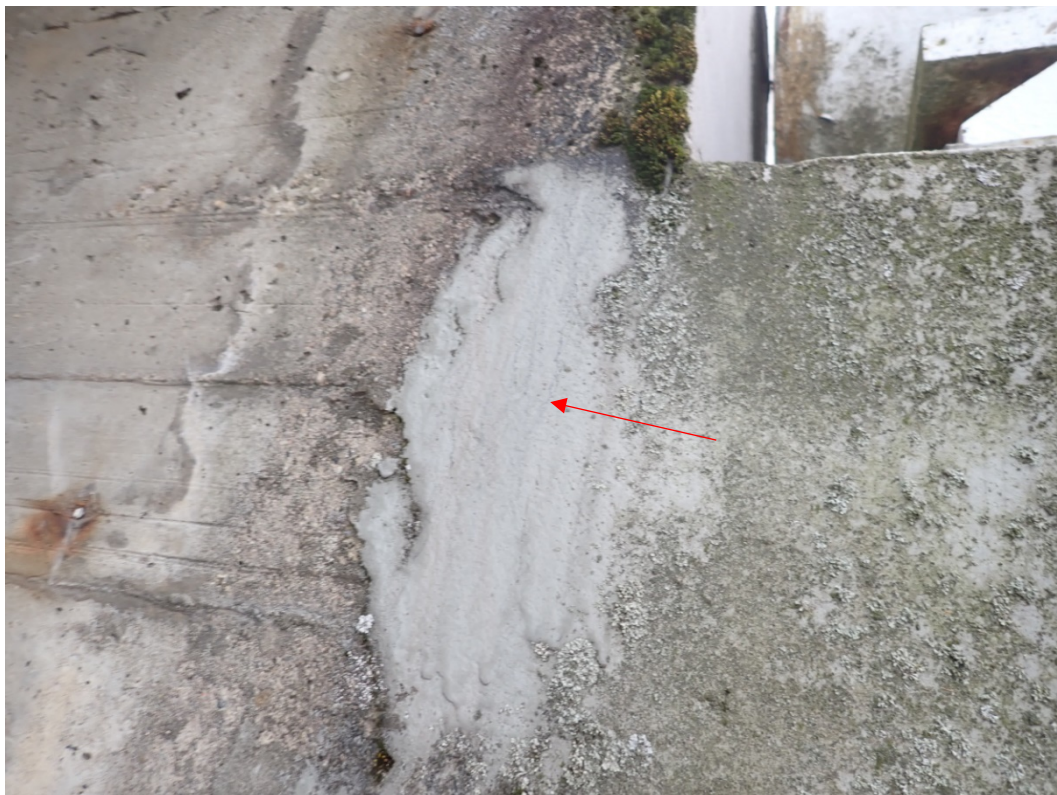
Foto 6: Šikmá vlasová trhlina do 0,1 mm na rozhraní vyšší/nížší části konzoly.
