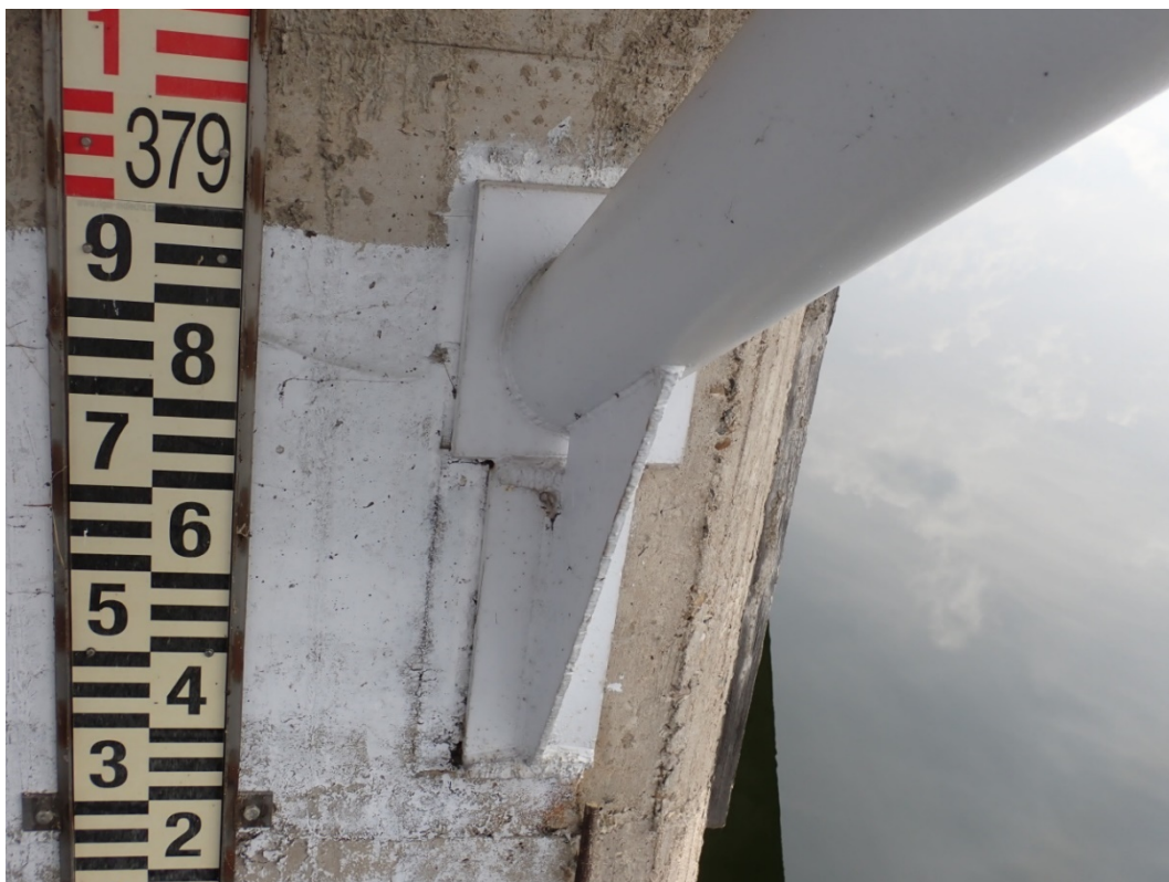
Foto 31: Kotvení šikmé vzpěry do stěny SO.
