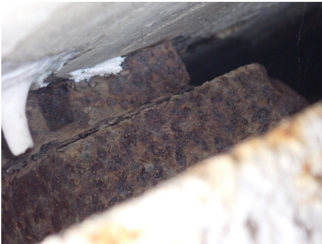
Foto 37: Mezi podpěrou a samotnou konzolou jsou instalovány ocelové klíny celkem 4x pro aktivaci podepření mezi ocelovou konstrukcí a žb. konzolou. Ocelové klíny jsou napadeny masivní korozí, úbytek odhadujeme v řádu 1 mm.
