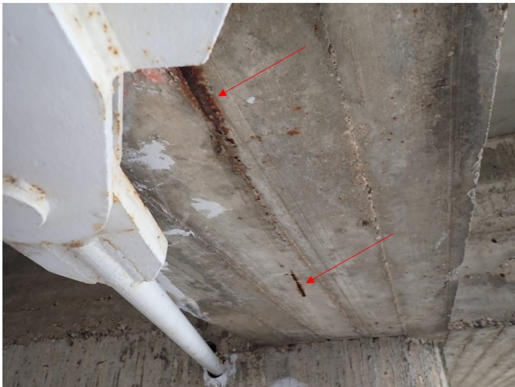
Foto 22: Koroze distančních podložek, malé krytí výztuže 2x.
