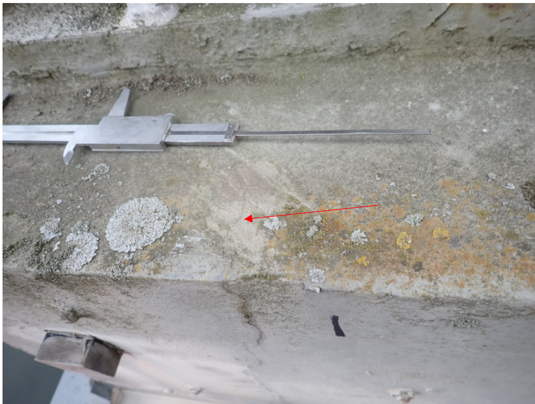
Foto 5: Svislá trhlina na čele konzoly 0,1 mm, do hloubky 110 mm.
