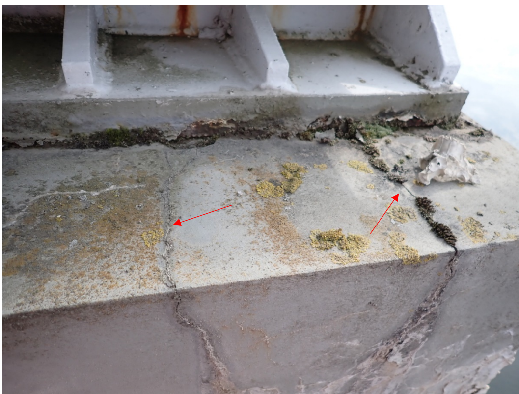
Foto 16: Svislá trhlina na čele konzoly 0,1 a 0,4 mm s výluhy, směřují pod ložisko cca 170 mm, degradace povrchových vrstev sanace.
