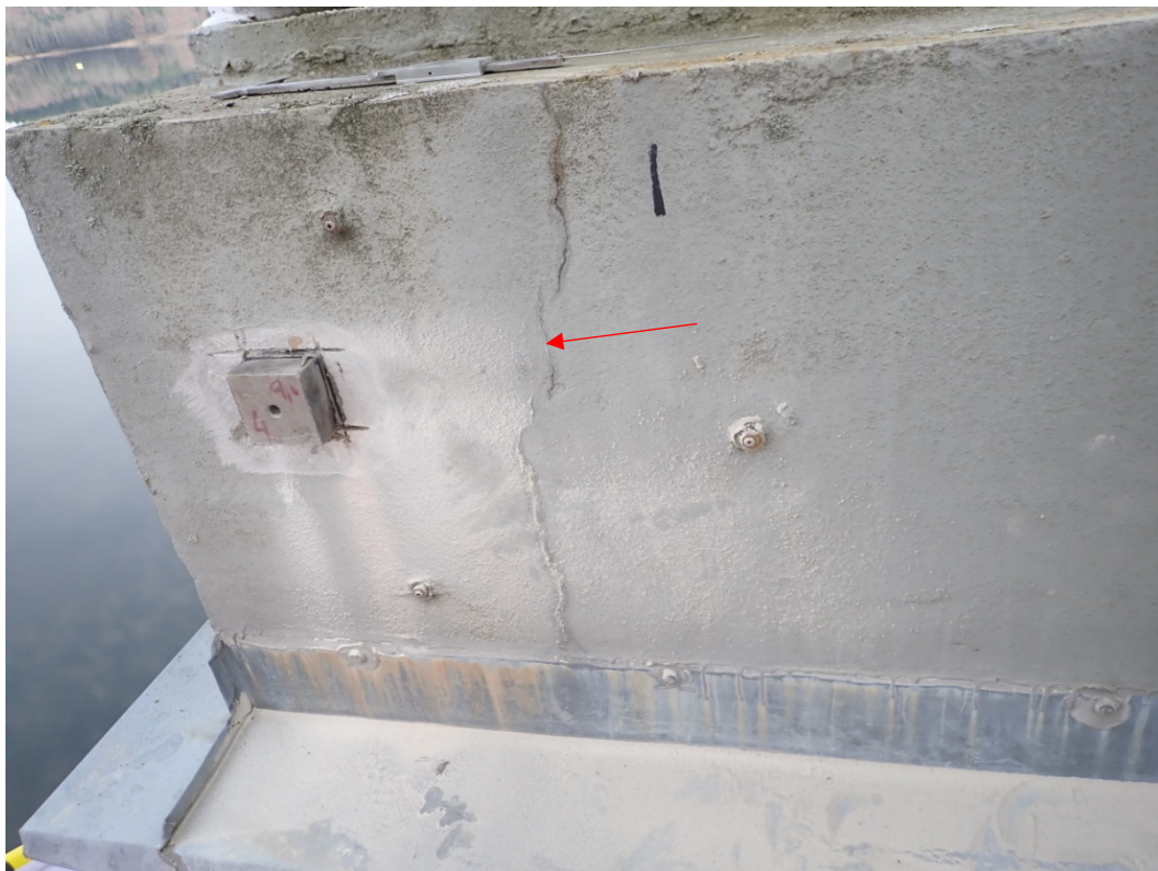
Foto 4: Svislá trhlina na čele konzoly 0,1 mm, do hloubky 110 mm.
