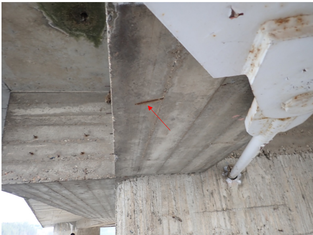
Foto 8: Koroze distančních podložek, malé krytí výztuže 2x.
