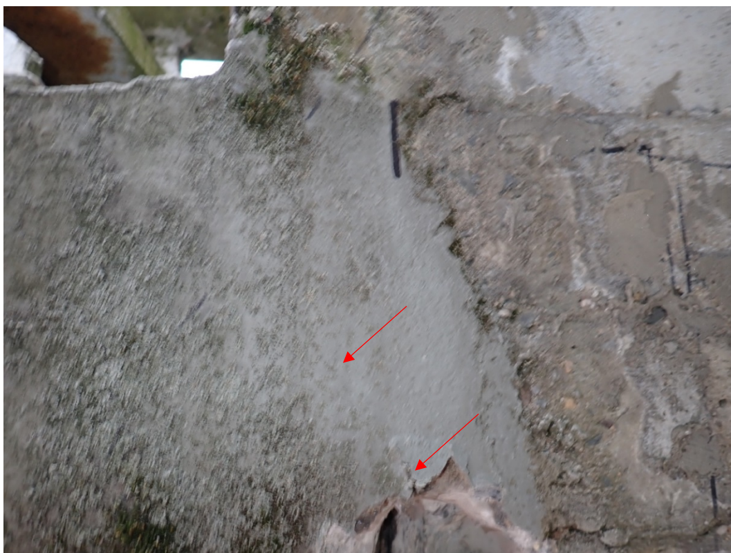
Foto 2: Šikmá vlasová trhлина do 0,1 mm na rozhraní vyšší/nížší části konzoly.
