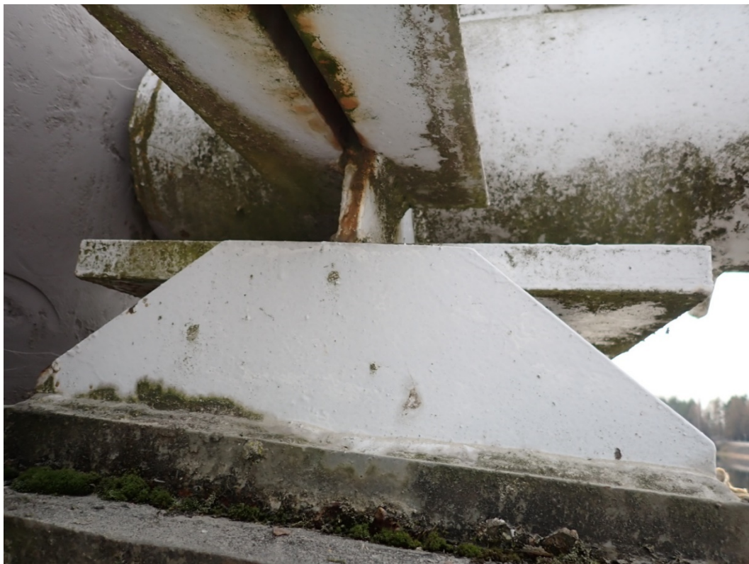
Foto 25: Boční vnitřní pohled na ložisko LK, lokálně loupání PKO korozní výluhy.
