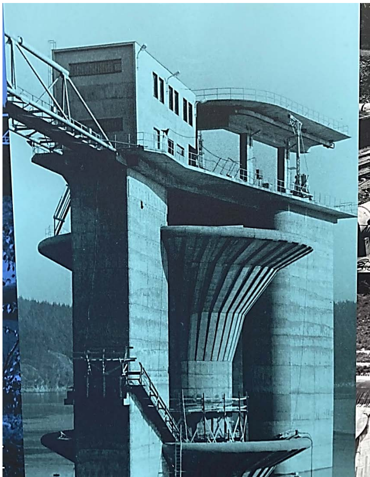
Obr. 5: Konzoly bez dodatečného podepření.
