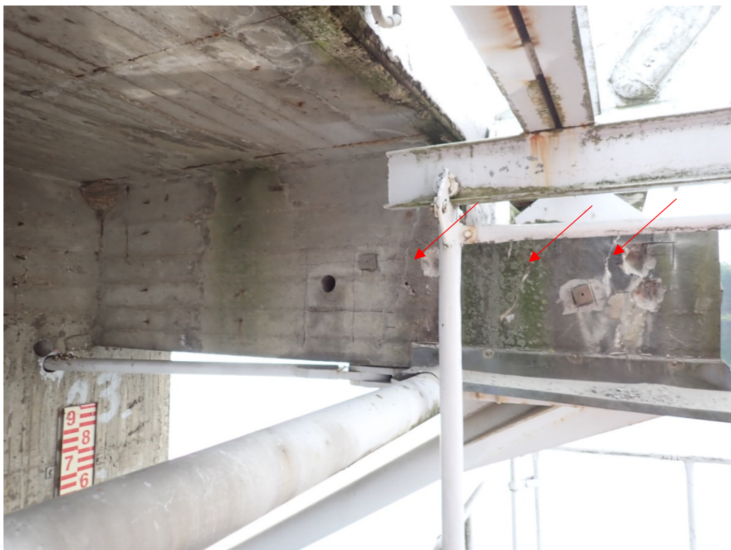
Foto 11: Šikmá vlasová trhlina 3x od čela šíře 0,4 mm, 0,1 a 0,05 mm s výluhy. První trhlina 170 mm od čela.
