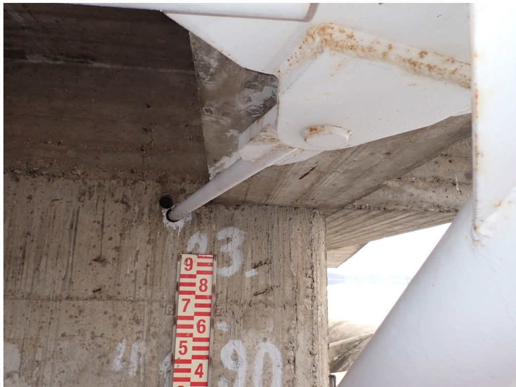
Foto 28: Horní táhlo dodatečného podepření, poškozené PKO, lokálně povrchová koroze.
