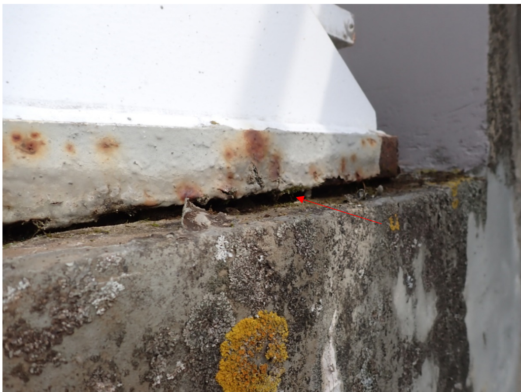
Foto 26: Boční vnější pohled na ložisko LK, mezi ložiskem a konzolou je do hloubky cca 100 cm mezera, ložisko není podbetonované v celé ploše.
