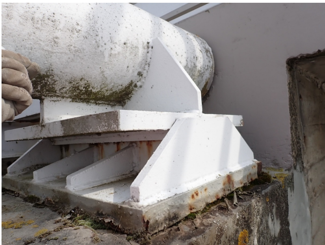
Foto 24: Boční vnější pohled na ložisko LK, lokálně loupání PKO korozní výluhy.
