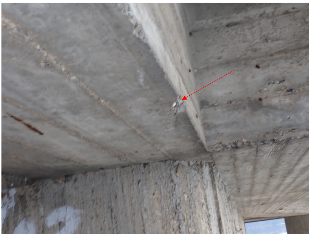
Foto 21: Trhlina na spodní části konzoly od koroze výztuže.
