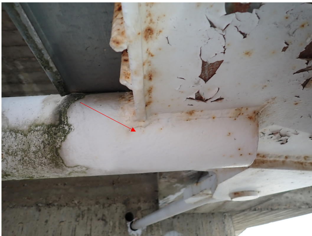
Foto 35: Příčná táhlo mezi podpěrami konzol, spoj táhla a podpěry, poškozené PKO, lokálně povrchová koroze.
