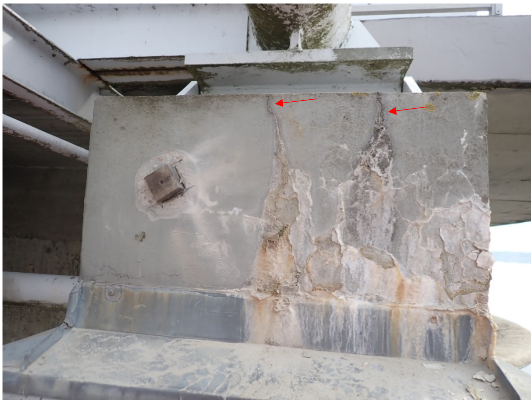
Foto 13: Svislá trhlina na čele konzoly 0,1 a 0,4 mm s výluhy, směřují pod ložisko cca 170 mm, degradace povrchových vrstev sanace.
