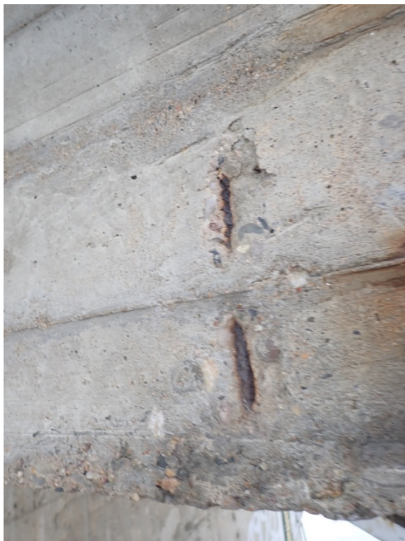
Foto 7: Koroze třmínků (bez významného oslabení), malé krytí výztuže 1x prut délka cca 20 cm.
